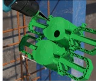
Con la broca escalonada de KAISER (n.º artículo 1284-32) se pueden realizar con precisión las aberturas necesarias en la parte posterior para tubos de hasta  $\varnothing$  25 mm.
