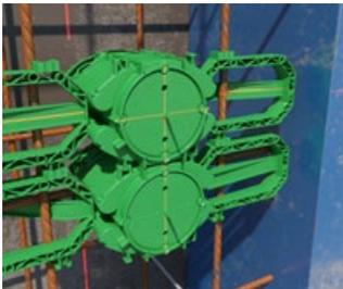
La marca central en la capa de yeso permite una alineación fácil y exacta de la caja de conexiones de dispositivos utilizando un nivel de burbuja láser.
