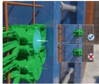
Las cerdas de señalización en las partes frontales de los artículos Prefix® mantienen la posición de las cajas de construcción de hormigón Prefix® visibles en la superficie de la pared.
