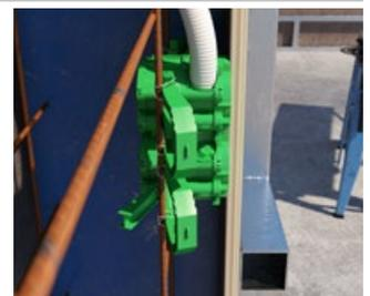
De este modo, las entradas de las tuberías se sitúan delante de la primera capa de refuerzo y quedan libres para uso sin restricciones. Las tuberías deben colocarse detrás de la armadura en la próxima oportunidad.
