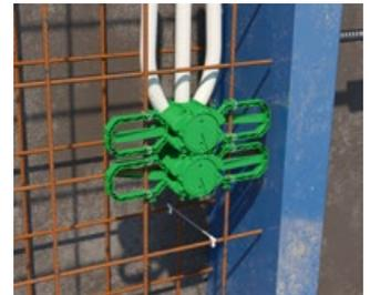
Puede utilizarse por ambos lados para cubiertas de hormigón de 20-40 mm o 40-60 mm.
