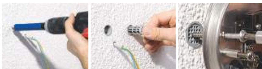
La **corona de metal duro de KAISER** (Ø 20 mm) abre los WDVS con precisión. El manguito de anclaje se introduce y luego se presiona el núcleo de fijación. Las puntas giratorias se anclan en el material aislante y dan al miniportaequipos una sujeción segura.
