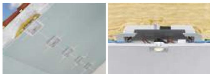
El **montaje** se realiza en el interior o sobre las vigas, directamente sobre los tableros tablero conglomerado tanto en los techos como en las paredes. La carcasa se atornilla fácilmente según el principio de la caja de pared hueca. La conexión con la lámina de control de vapor se vuelve a hacer estanca al aire con el **marco de sellado EnoX®**. Después de fijar el entarimado, tendrá un espacio de instalación aislado y protegido térmicamente para luces, altavoces, pantallas y mucho más.
