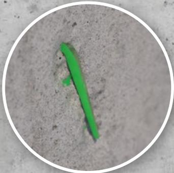
Cerdas de señalización para facilitar la recuperación de las cajas después del desencofrado
